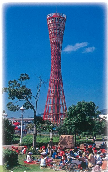
神戸ポートタワー
